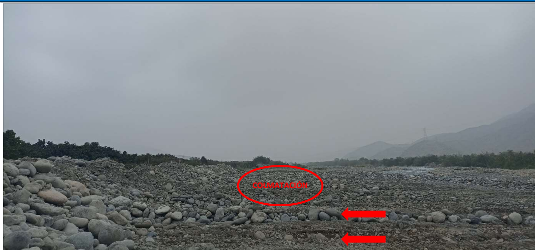
FIGURA N°01: RIO CHANCAY - HUARAL COLMATADO EN EL SECTOR HORNILLOS - LA ESPERANZA, CON LA PRESENCIA DE: PLANTAS, ARENA FINA Y MATERIAL GRANULAR; LAS CUALES DEBEN SER DESPLAZADOS HACIA AMBOS MARGENES PARA MANTENER SU SECCIÓN HIDRÁULICA .
