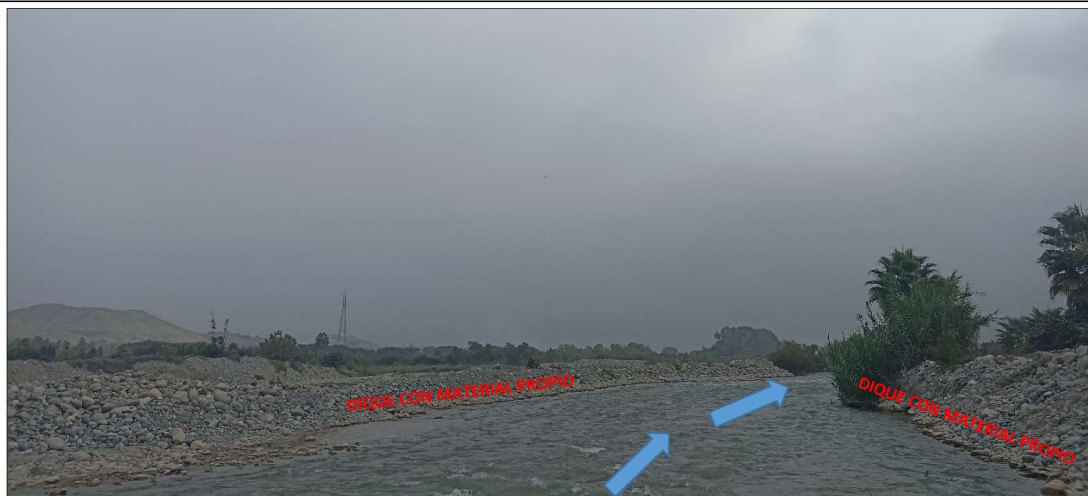
FIGURA N°02: AMBAS MÁRGENES DEL RIO CHANCAY - HUARAL CON DIQUE DE PROTECCIÓN EN MAL ESTADO, POR TAL MOTIVO ES VULNERABLE A LAS VELOCIDADES EROSIVAS DEL RIO PRODUCIENDO DESBORDES DEL CAUCE DEL RIO, EN EL SECTOR HORNILLOS - LA ESPERANZA DEL DISTRITO DE HUARAL - AUCALLAMA .
