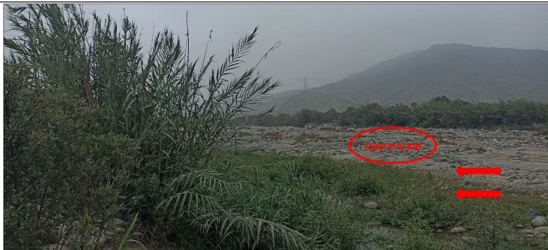
FIGURA N°03: TRAMOS EN EL MARGEN IZQUIERDO DEL RIO CHANCAY - HUARAL CON DEFENSA VIVA Y MATERIAL GRANULAR, OCASIONA QUE EL DESBORDAMIENTO DEL CAUCE DEL RIO SEA MAS INMINENTE EN EPOCAS DE AVENIDAS.
